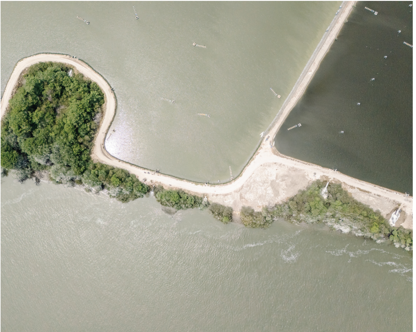
Los manglares cubren parcialmente un dique que separa los estanques de una camaronera de un gran canal. El agua de uno de los estanques se drena mediante tuberías hacia el canal.
